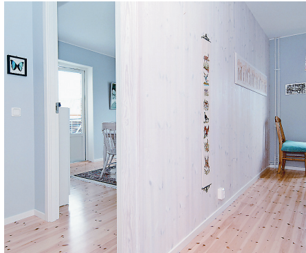
Figur 3: Exempel på en synlig bärande massiv trävägg (CLT). Flerbostadshus i Inre Hamnen i Sundsvall.
